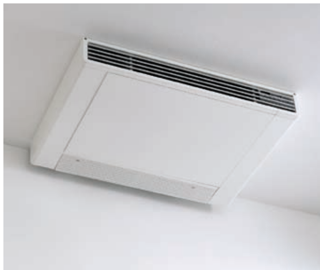
Фанкойл закреплен на потолке
